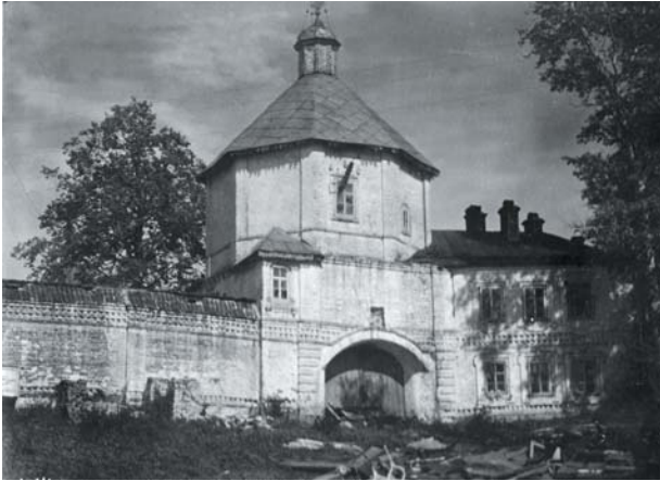
Надвратная церковь Феодора Стратилата. Фото 1930 г.
