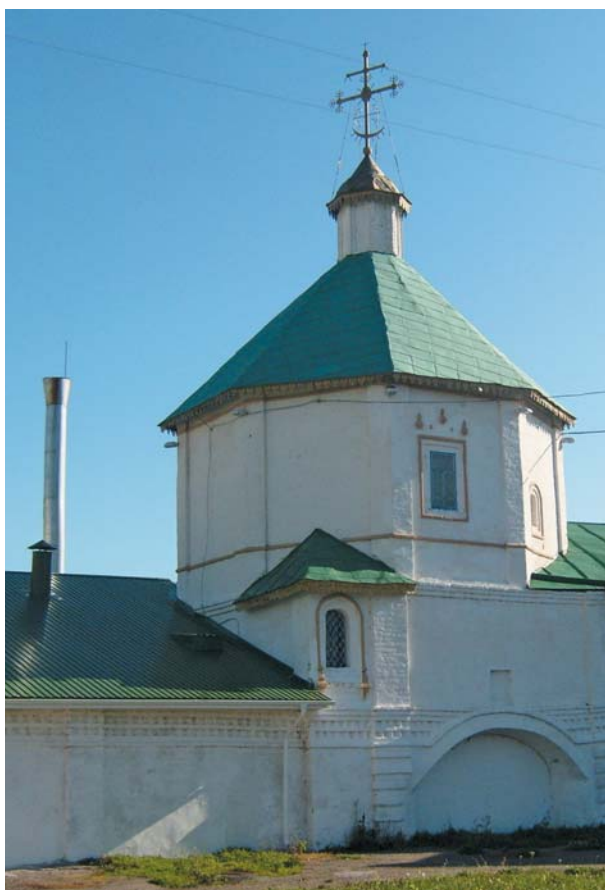
Надвратная церковь Феодора Стратилата. Современное состояние здания.
